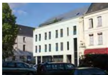
La nouvelle construction
